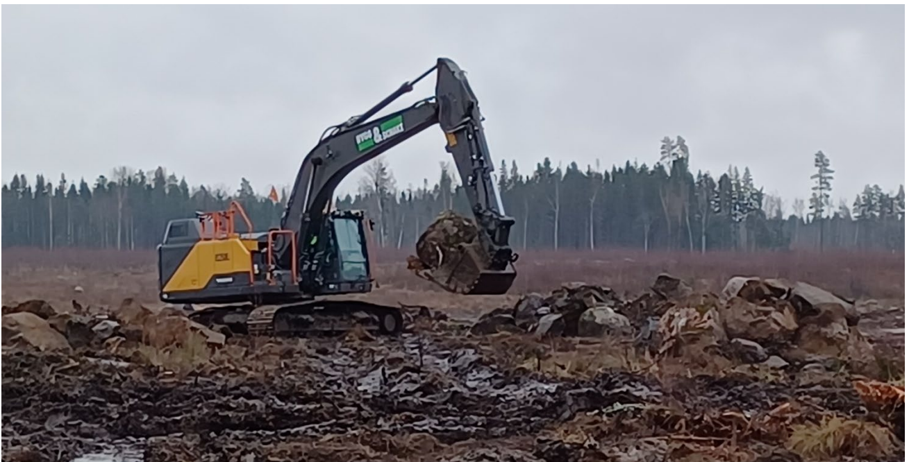
Figur 11- Byggnation av solcellspark i skogsmark i Vingåker hösten 2025. En grävmaskin samlar ihop sten och block som sedan samlas ihop i stenuplag.
