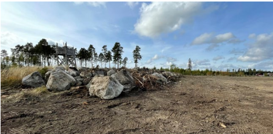
Figur 9-Bild från byggnation av Kungsåra solcellspark utanför Västerås som delvis är uppförd på skogsmark. Här har ett delområde rensats från större block och samlats ihop till stenupplag.
