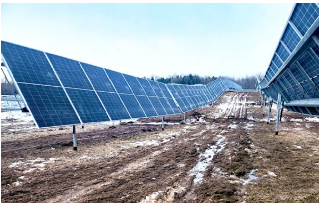
Figur 29-Exempel på solceller i något kuperad mark Solcellsmodulernas sektioner används för att ta upp höjdvariationer. En solcellspark i skogsmark med höjdvariationer kommer att bölja över området.
