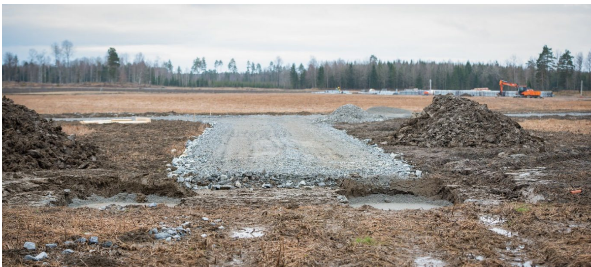
Figur 23. Exempel på en grävd grund för en transformator (hitom vägen i bilden) och en anlagd grusväg. Grundläggningen för transformatorn utgör de två groparna hitom grusvägen i bild. I det här fallet ligger solcellsparken som byggs på jordbruksmark.
