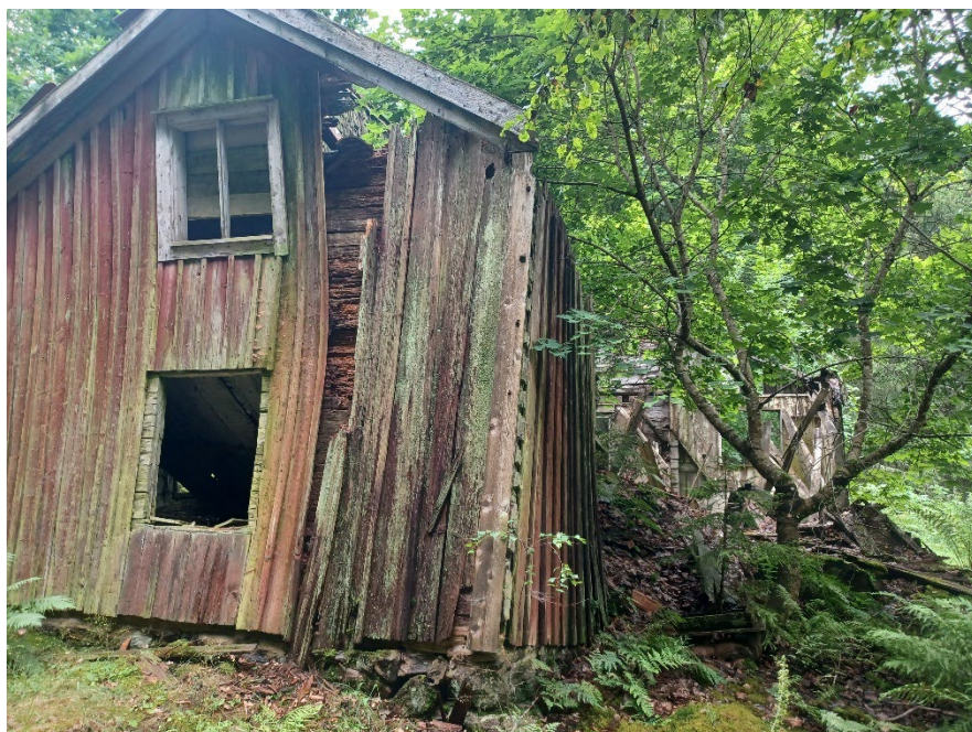
Figur 72 – Bebyggelselämning i L1952:6736. Denna ligger i västra delen längs väg nära kraftledning och utelämnas från projektområdet på grund av det. Enda byggnaden inom projektområdet.
