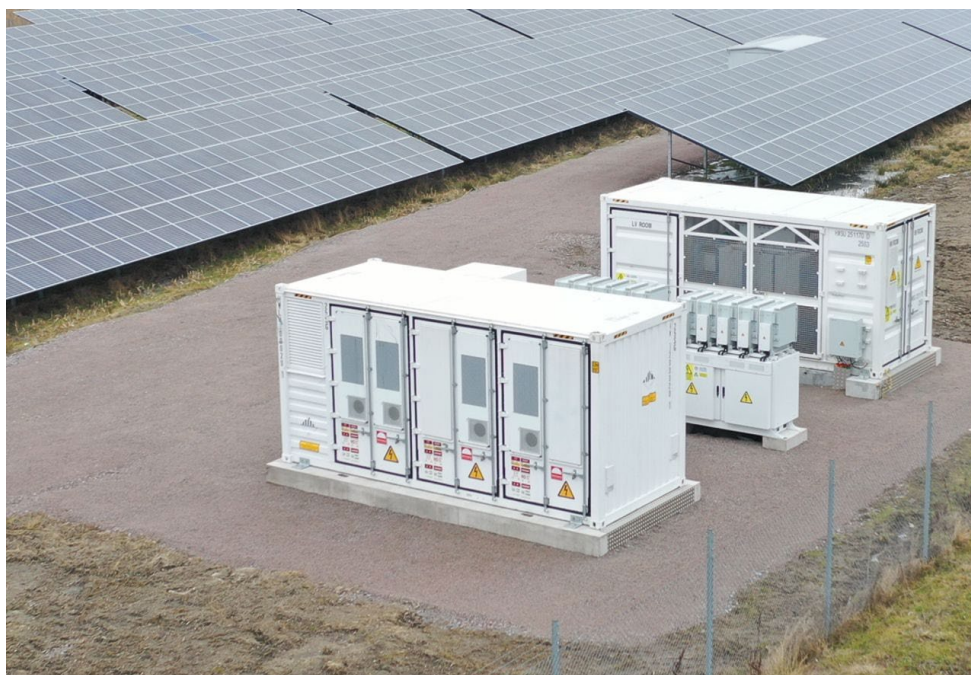
Figur 38. Exempel på samlokalisering av solceller och batterilager.
