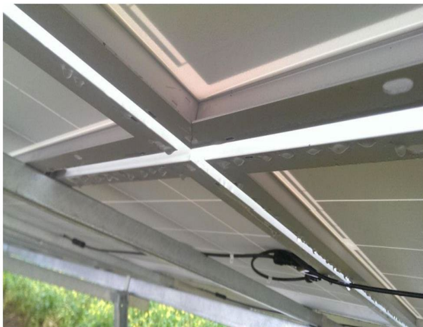
Figur 84. Fotodetalj under solcellsrad som visar mellanrum genom vilka vatten kan rinna.
