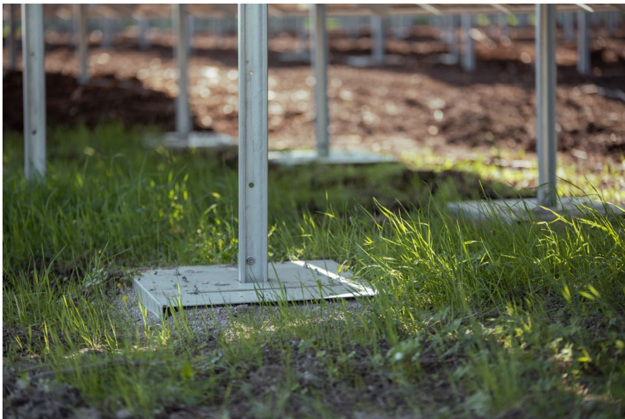
Figur 16-Om marken har dålig bärighet kan stålprofilerna behöva förstärkas med plattor vilket syns på bilden ovan. Om plattorna grävs ner under mark ökar motståndskraften mot vindlyft.
