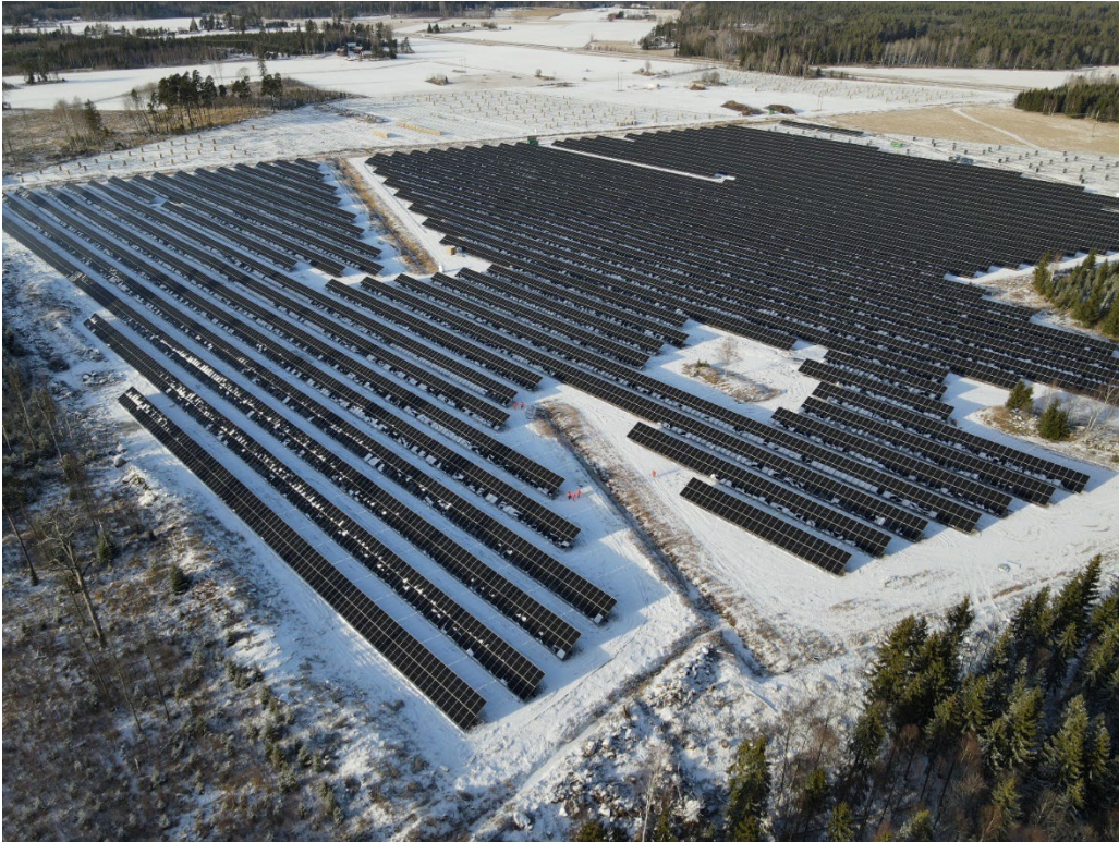
Figur 7. Exempel på byggnation och layout av solcellspark, Kungsåra Västerås februari 2023. Drönarfoto. På bilden framgår tydligt att områden längs diken och runt åkerholmar undvikits som hänsynområden. Delar av området byggdes på skogsmark. I Engaholm kommer diken, naturvärden och kulturmiljöområden att utelämnas.
