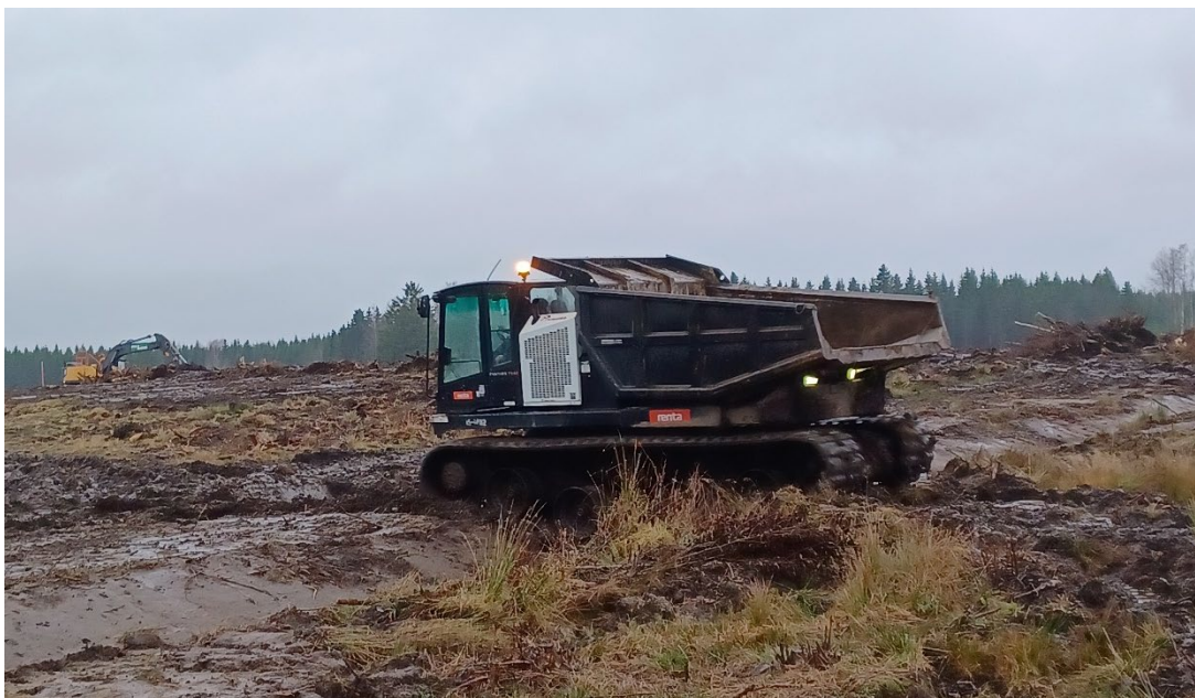
Figur 12- Byggnation av solcellspark i skogsmark i Vingåker hösten 2025. En mindre dumper kör i väg sten och block till stenupplag. Mindre ojämnheter som uppstår efter att sten och block grävts upp jämnas till.
