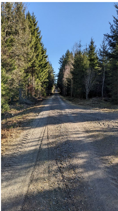
Figur 22. Exempel på befintlig grusväg inom projektområdet ovan. Beroende på mjukhet kommer vägarna förstärkas. Även mötesplatser kan behöva anläggas för transporter och arbetsfordon liksom att kurvradier i en del vägkorsningar behöver ökas.
