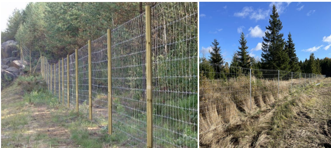
Figurer 13-Exempel på utförande av stängsel, viltstängsel på trästolpar till vänster och stålstolpar till höger.
