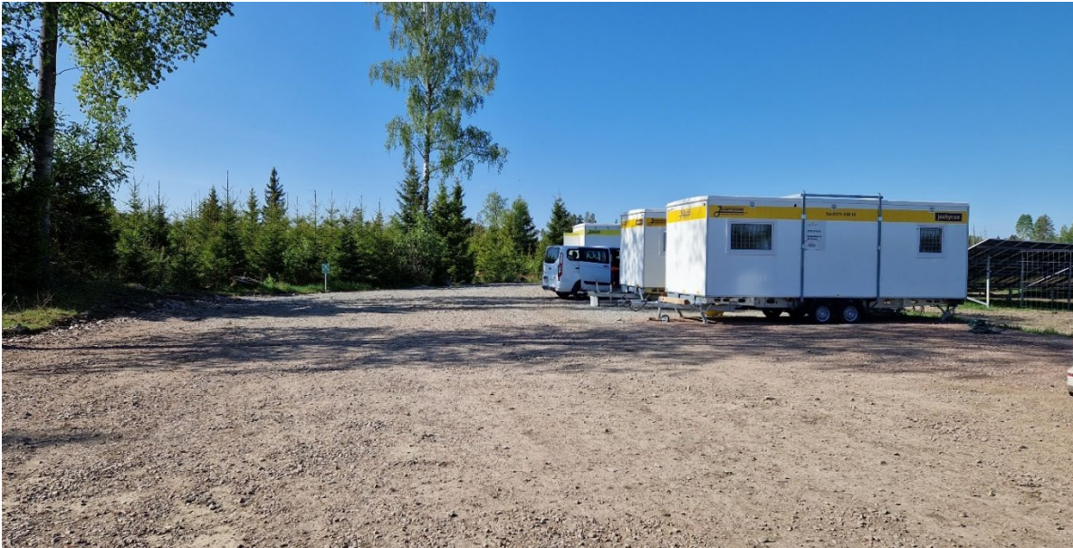
Figur 41. Uppställningsplats för arbetsbodar, parkering och materialupplag i anslutning till solcellspark Kungsåra utanför Västerås.
