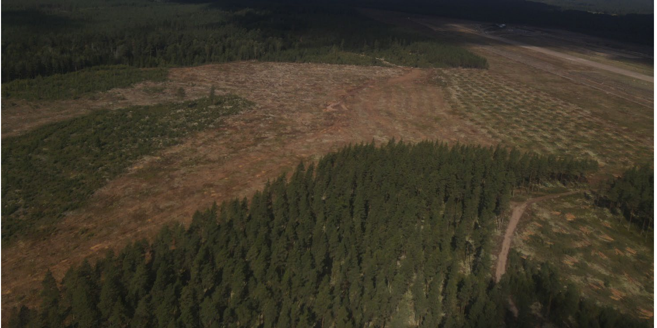
Figur 7- Drönarfoto över område invid Hultsfreds flygplats där en större solcellspark på skogsmark kommer att byggas. Till höger syns f.d. landningsbana där även solceller kommer att anläggas av ett annat bolag. Centralt i bilden syns avskogade områden som omvandlas till solbruk. Från ett helikopterperspektiv blir en solcellspark i skogsmark en påtaglig förändring.
