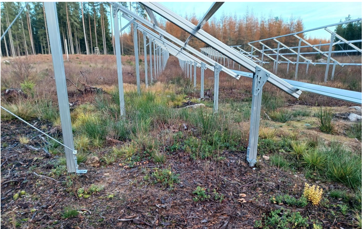
Figur 17. Markställningar till solcellspaneler monterade på flack, tidigare skogbevuxen mark. Här med markskruv. I denna marktyp kan markskiktet lämnas relativt opåverkat.
