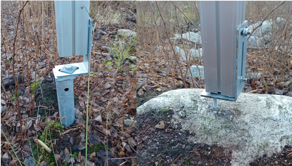
Figur 15. Vänster: förankring av stålställning med hjälp av markskruv. Höger: förankring av stålställning i block/berg.
