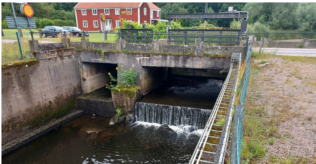
Figur 81 – Gransholms vattenkraftverk uppströms i Helige å har stor betydelse för regleringen av vattenflödet i Helige å.
