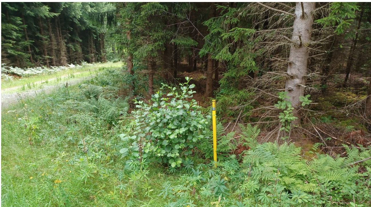
Figur 92. Gul markeringskäpp för elkabel. I väggkant längs väg i västra delen av projektområdet.
