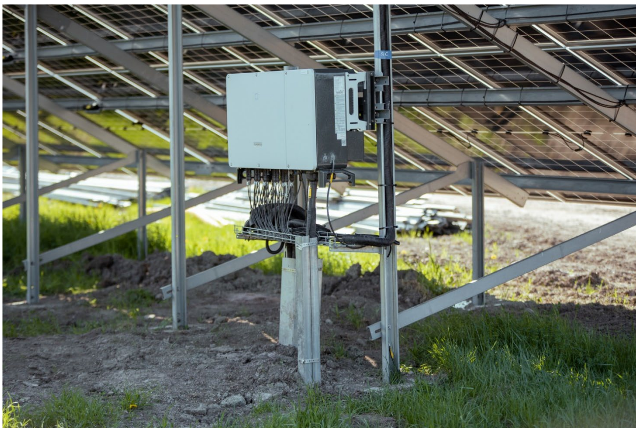
Figur 17-Exempel på växelriktare för konvertering av solcellsmodulernas likström till växelström.
