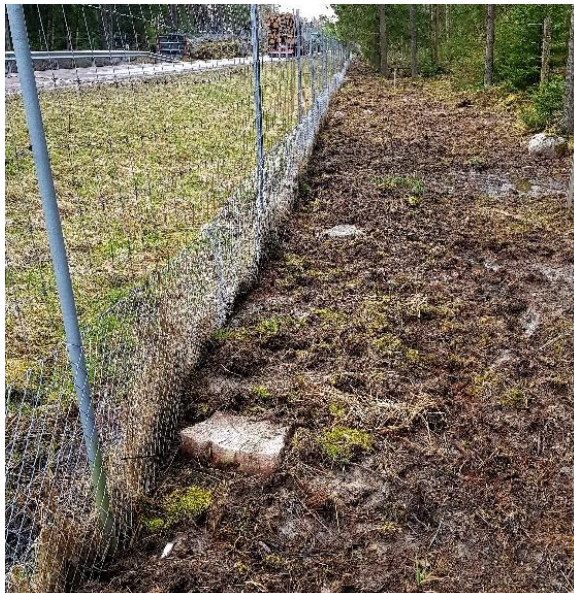
Figur 9. Exempel på viltstängsel som har kompletterats med finmaskigt nät nedtill.
