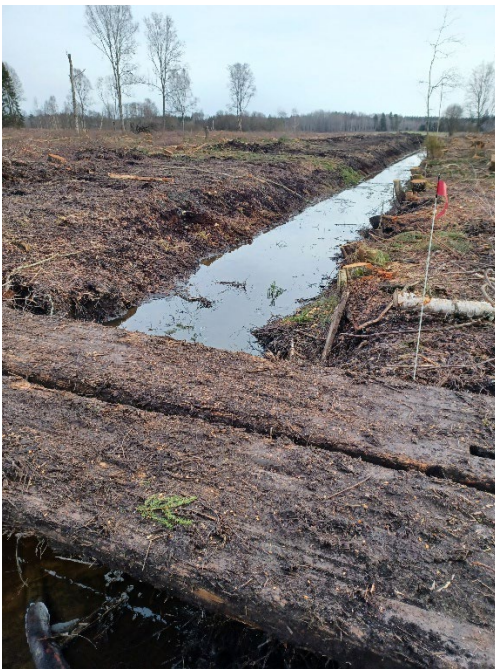
Figur 24. Exempel på överfart över dike med hjälp av stockmattor/slipers i trä i annat projektområde. Denna metod kan komma att användas liksom trummor, halvtrummor, överfartsplåtar och betongbalkbroar.
