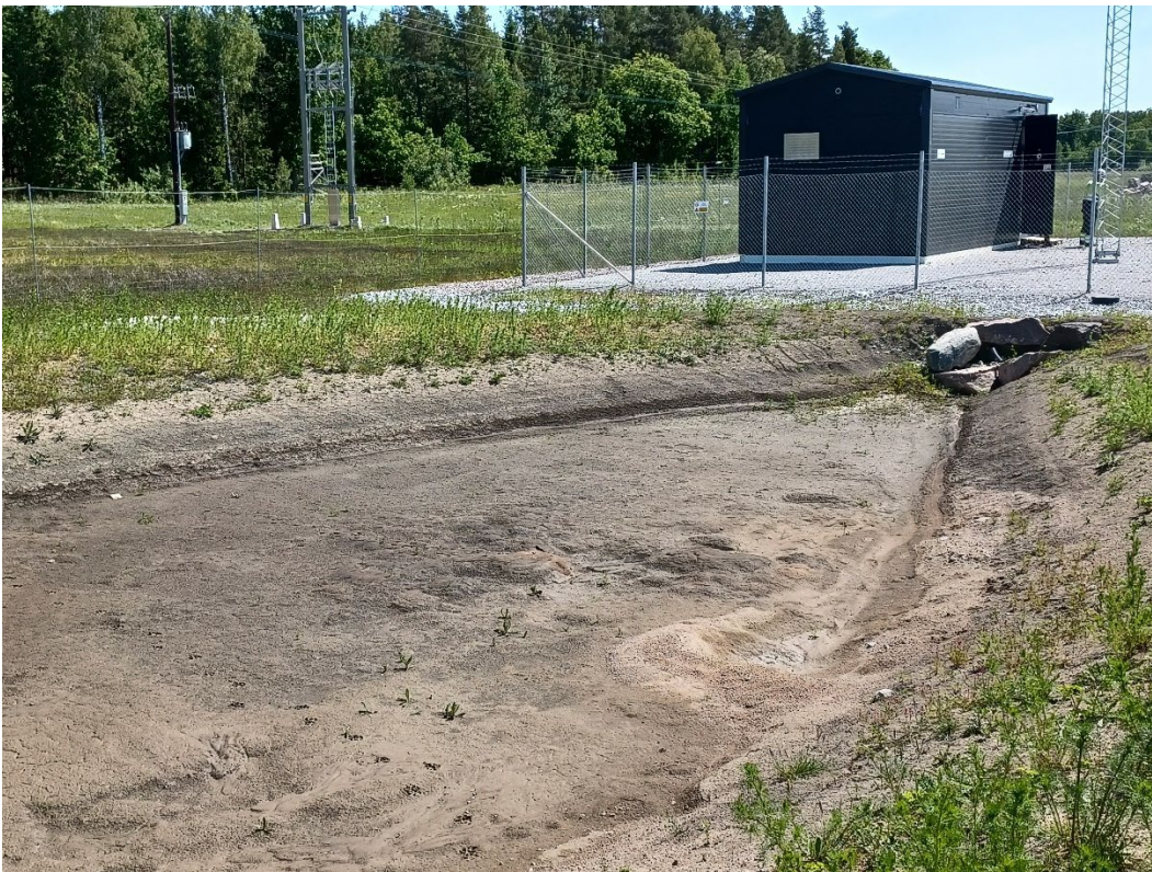
Figur 57 - Exempel på torrdamm för att omhänderta tillfälliga vattenflöden från en transformatoranläggning vid solcellspark Lindesberg, Örebro län. Liknande anläggningar kommer att anläggas för att fördröja tillfälligt höga flöden i Engaholms solcellspark. Även invid battericontainerområdet kommer liknande dammanläggning att utföras.
