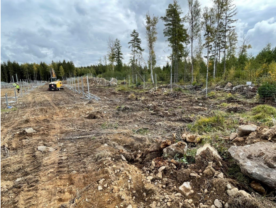
Figur 8 - Bild från byggnation av Kungsåra solcellspark utanför Västerås som delvis är uppförd på skogsmark. Stängsel har satts upp och arbete med pålar/stålprofiler pågår på bilden.
