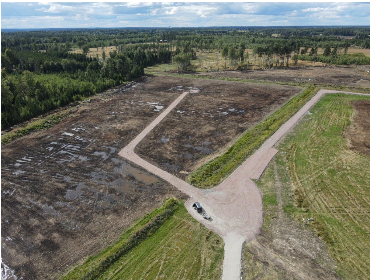
Figur 62. Solcellspark under konstruktion. Till höger i bild har marken brukats som jordbruksmark och till vänster som skogsmark. Byggvägar fram till transformator har här anlagts.
