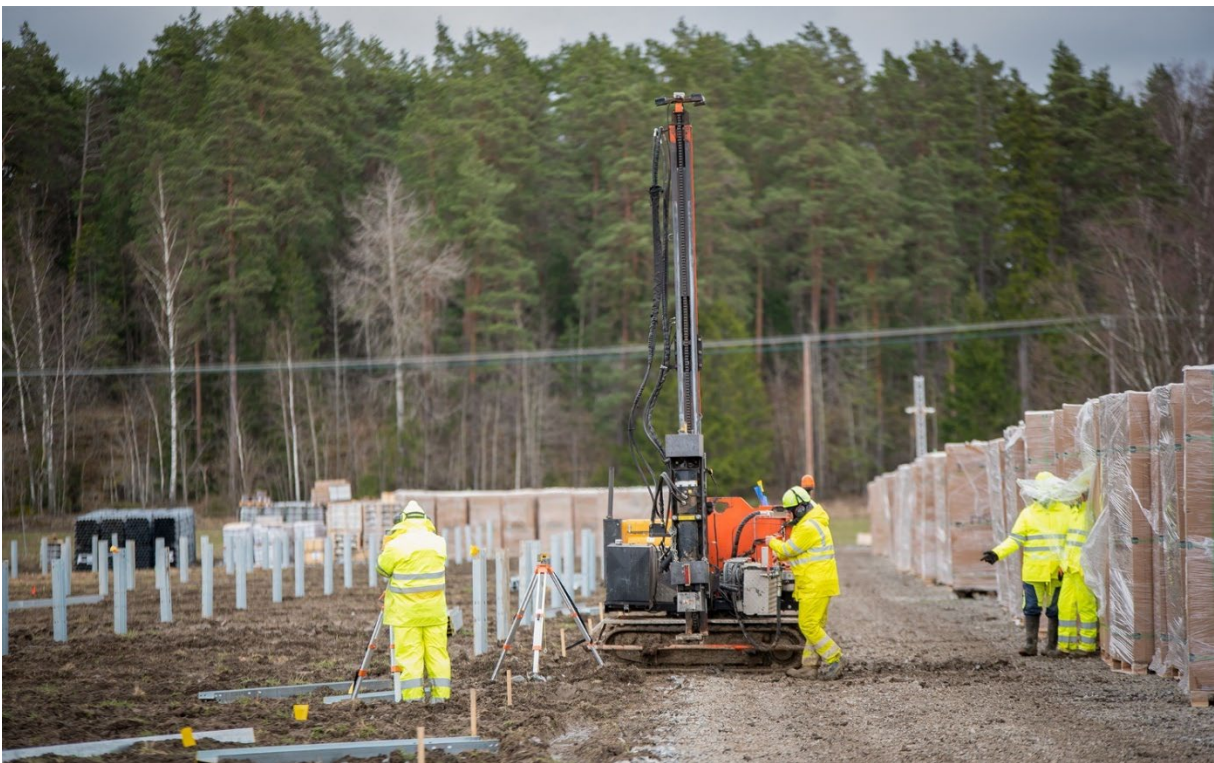
Figur 21-Exempel på pålningsmaskin på larvfötter för installation av pålar.
