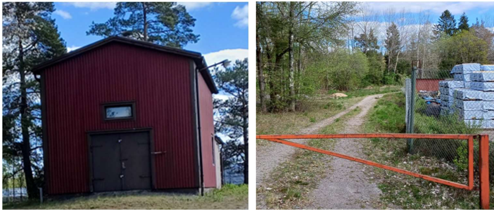
(Vänster) Mottagningsstation, dvs. el-stationen (Höger) Grusvägen längs industriområdet med bom/utfart.
