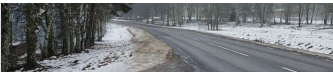
Torpsbruksvägen (väg 739) norrut från befintlig utfart (Ovan), Torpsbruksvägen söderut från befintlig utfart (Nedan)
