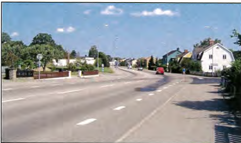
Foto taget mellan Villagatan och Trädgårdsgatan visar vägens karaktär vilken består av en bred körbana och bristfälliga gång- och cykelmöjligheter.
