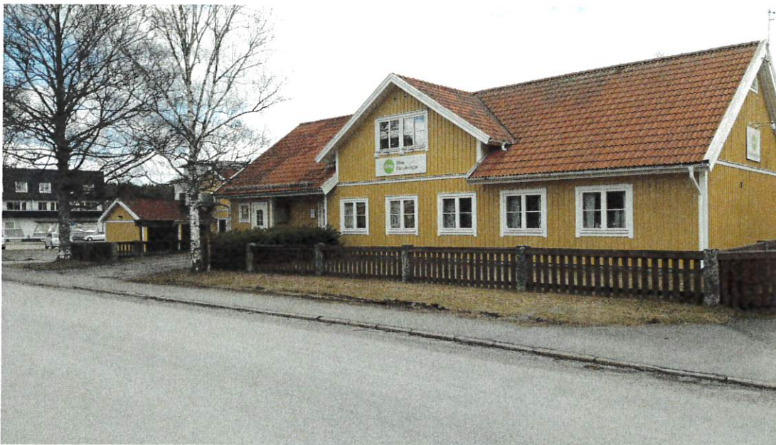
Befintlig bebyggelse norrifrån
