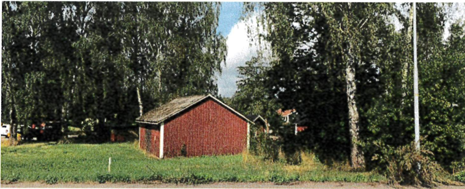
Vagnslidret i de södra delen av planområdet.
