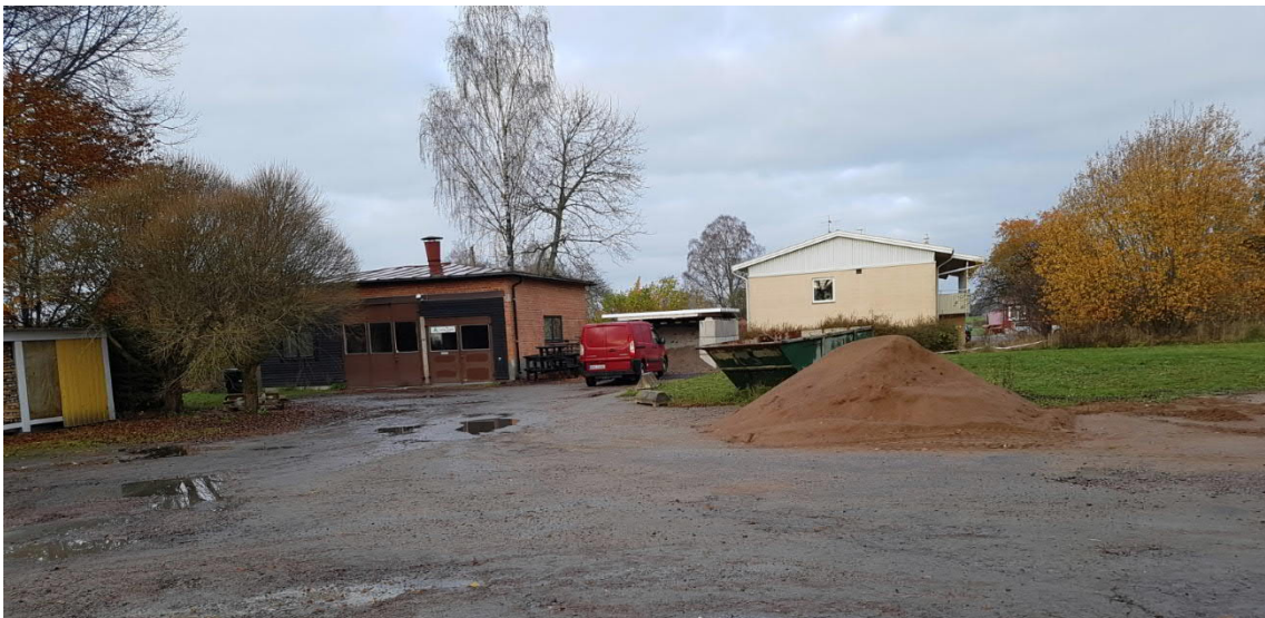
Figur 9. Foto över befintlig konstruktion inom undersökningsområdet mot syd, taget vid platsbesök 2019-10-23.
