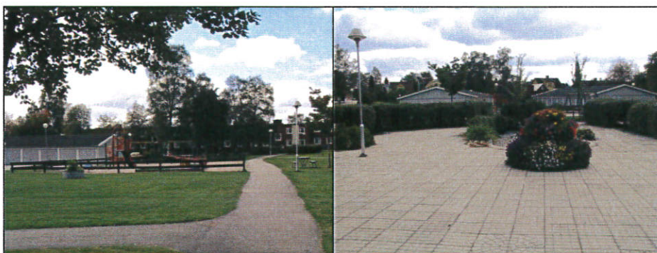
Planområdet består idag bland annat av gräsytor, asfalterade gångvägar, lekplats och plattbelagda ytor. Foto Elinor Bjärnberg
