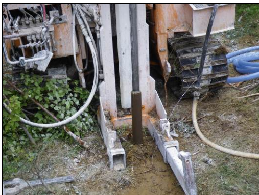
Foto 1: Utförande av direktinjektering
