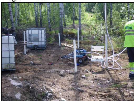
Foto 2: Injektering av kemsikt oxidationsmedel, RegenOx, i installerade brunnar.
