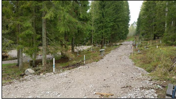
Foto 3 och 4: Installation av brunnar MFE område (inom B1 och B2). För att senare kunna komma fram med behandlingsmedel har transportvägar byggts. Det är ett svårtillgängligt område och en del skog har avverkats för att det skall fungera.
